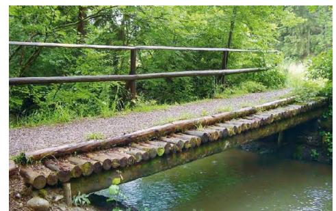
PONTE RICOPERTO CON GHIAIA
