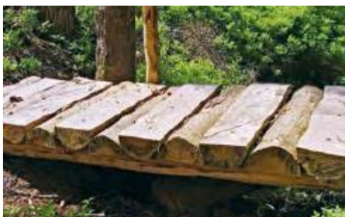
PIANO DI CALPESTIO CON PALI DI LEGNO DIMEZZATI
